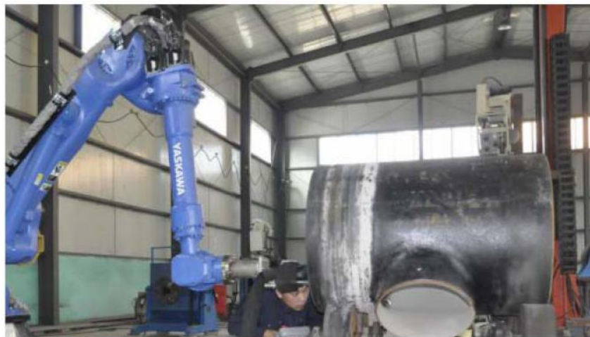
常减压塔顶管线
